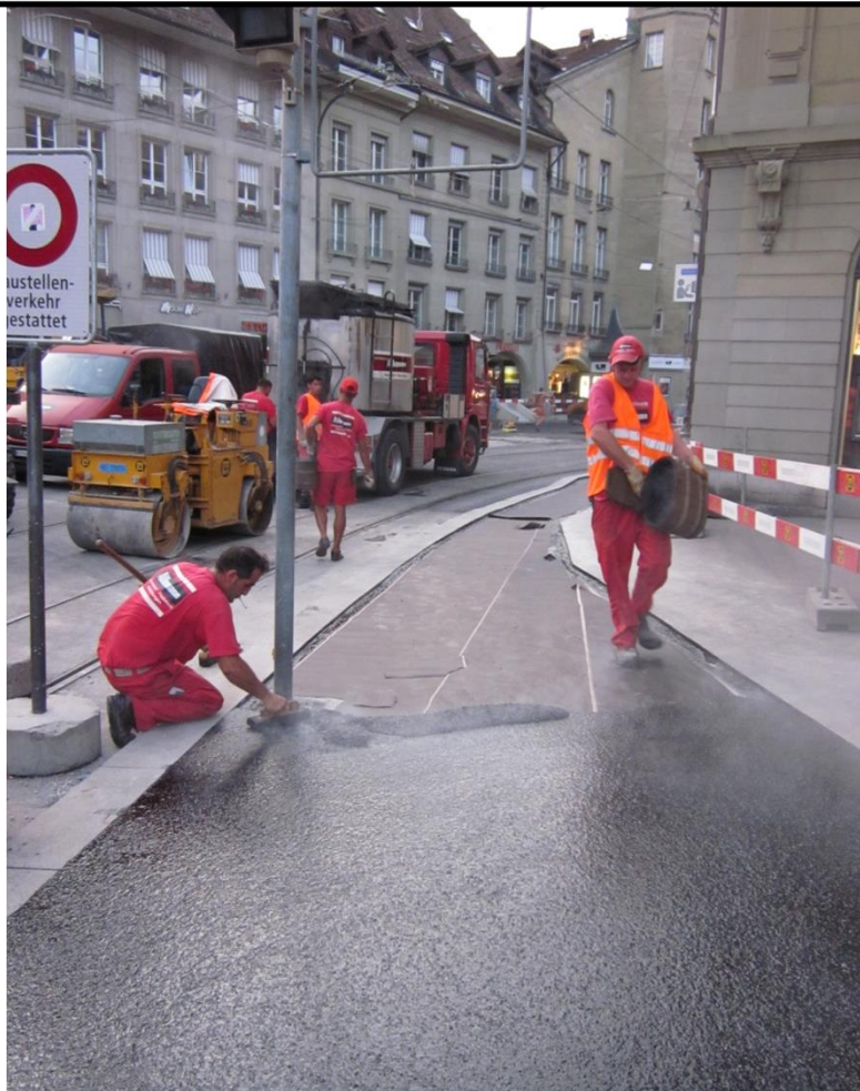
Asfalto colato marciapiedi Berna (Svizzera)
